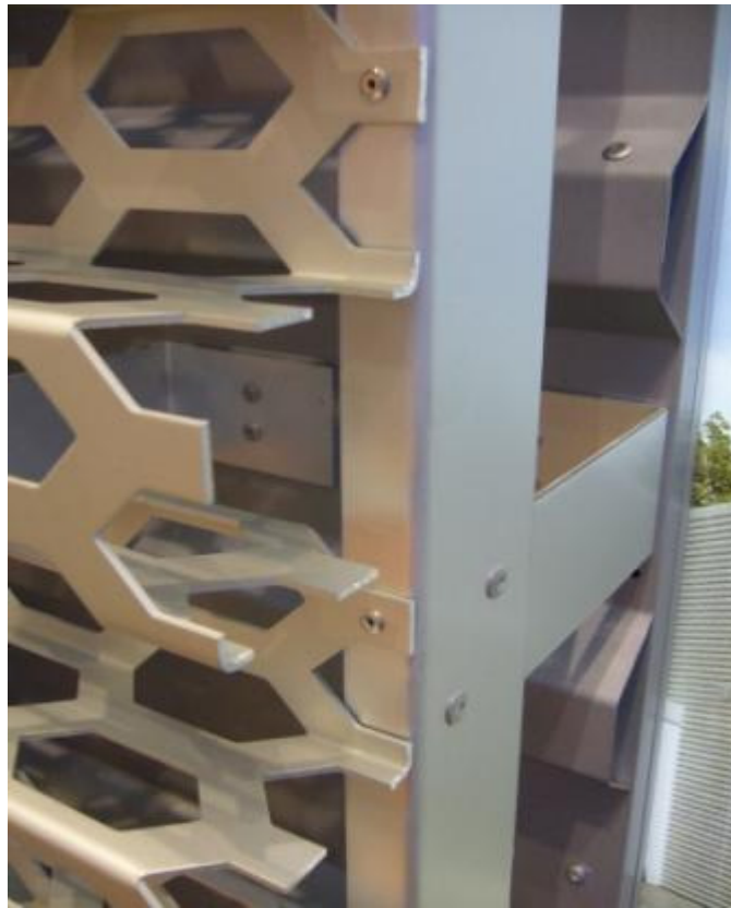
Beispiel: Vernietung Aluminiumprofil an Seitenwinkel + Vernietung Seitenwinkel an Trapezblech Fassade Vernietung an Fassade erfolgt zwischen den Wellen . Anschließend Vernietung Lochblechpaneel an Aluprofilträger
