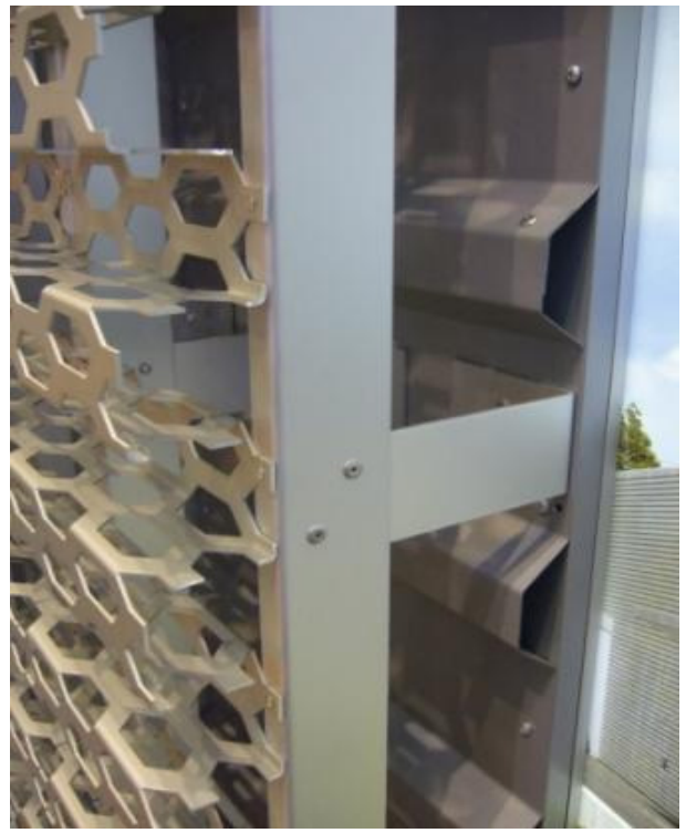
Beispiel: Vernietung Aluminiumprofil an Seitenwinkel + Vernietung Seitenwinkel an Trapezblech Fassade Vernietung an Fassade erfolgt zwischen den Wellen . Anschließend Vernietung Lochblechpaneel an Aluprofilträger
