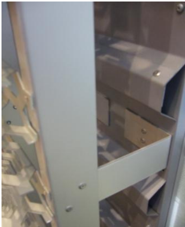
Beispiel: Vernietung Aluminiumprofil an Seitenwinkel + Vernietung Seitenwinkel an Trapezblech Fassade Vernietung an Fassade erfolgt zwischen den Wellen . Anschließend Vernietung Lochblechpaneel an Aluprofilträger
